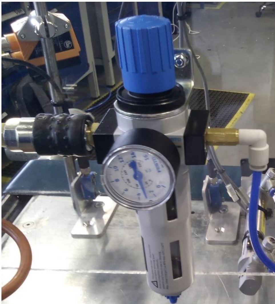
Fig.4.14 Grup de preparare aer comprimat
